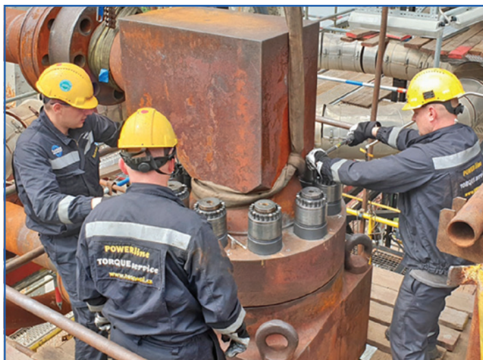
Finální utažení T-kusu čpavkového reaktoru. Zde jsme kompletně měnily systém utěsnění i utahování.
