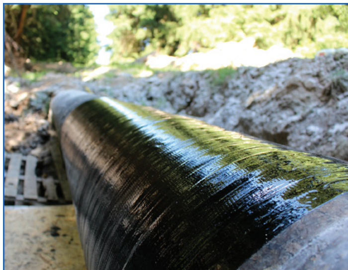
Stav po oprave
