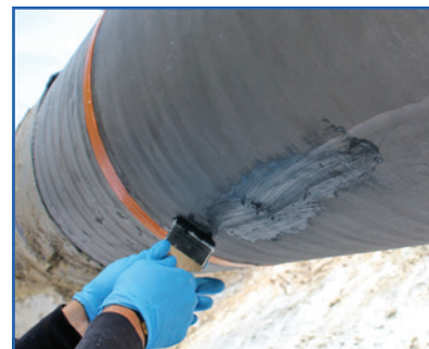
Aplikácia výplňového tmelu
