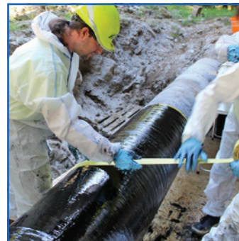
Omotávanie jednotlivých závitov
