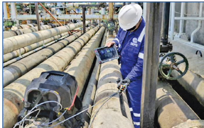
Kontrola potrubia pod podperou
